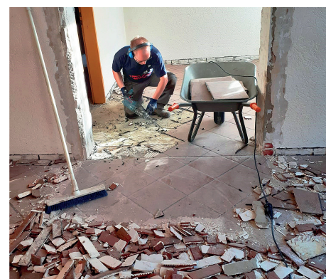
Die Bürger leisten auf der Baustelle Schwerstarbeit Foto: Allers
