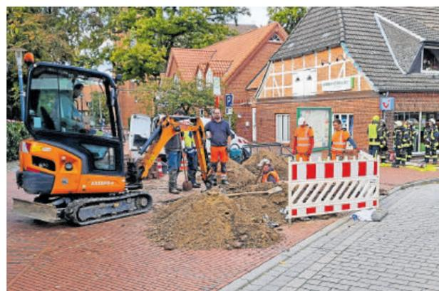
Blick auf die Einsatzstelle in der Harsefelder Marktstraße: Bauarbeiter dichten die defekte Gasleitung ab.
